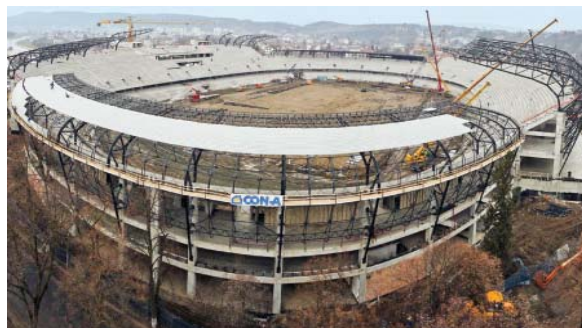
2011 - Stadionul „Cluj-Arena” în plin șantier, se pregătește pentru inaugurarea din acest an.
